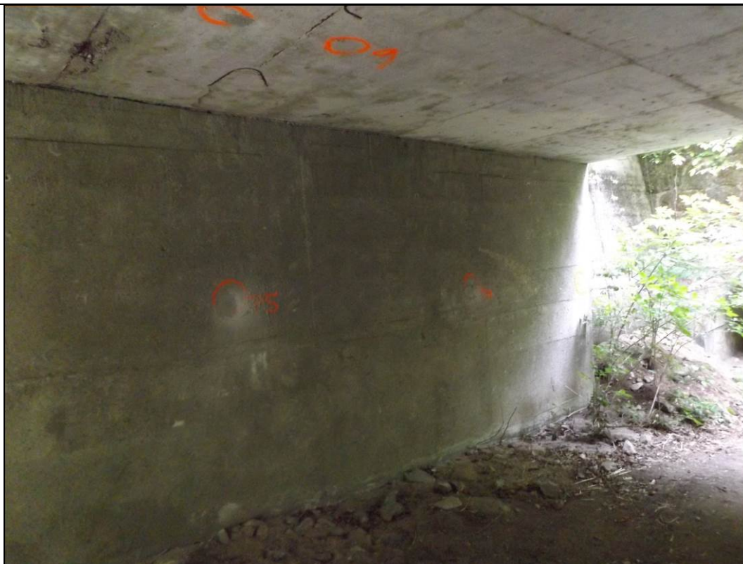
Obr. č. 8 - pohled na opěru Adamov, včetně míst s odtrhovými zkouškami P5 a P6
