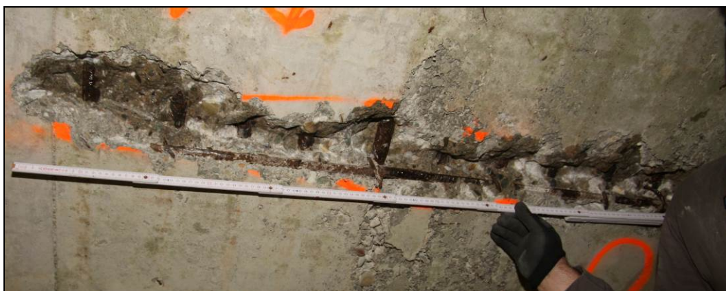
Obr. č. 11 - detailní pohled na sondu do spodního líce NK pro ověření výztuže a jejího korozního stavu. Výztuž je většinou s povrchovou korozí (60%) a místy bez koroze (40%)
