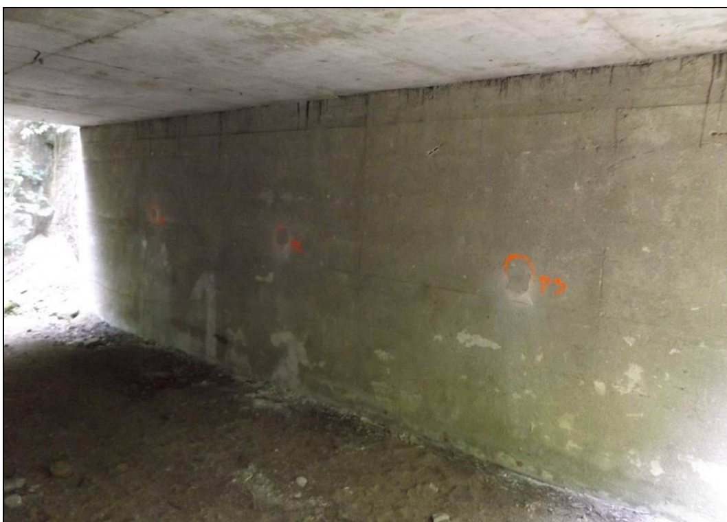
Obr. č. 7 - pohled na opěru Maloměřice, včetně míst s odtrhovými zkouškami P1 - P3
